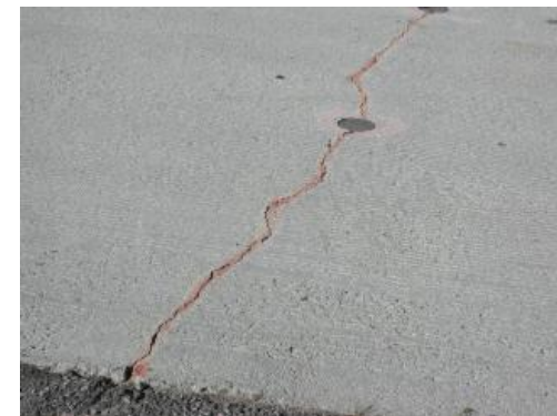
Vết nứt xuyên do nhiệt trong bê tông
