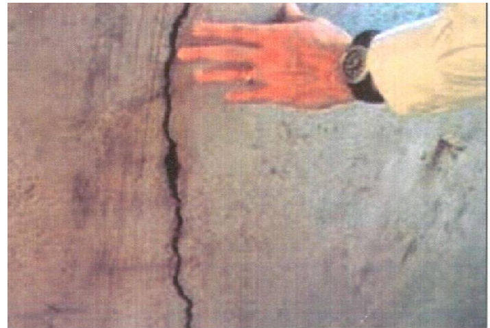
NÚT RÃNH SÂU BT KHỐI LỚN, THIẾU THÉP CẤU TẠO
